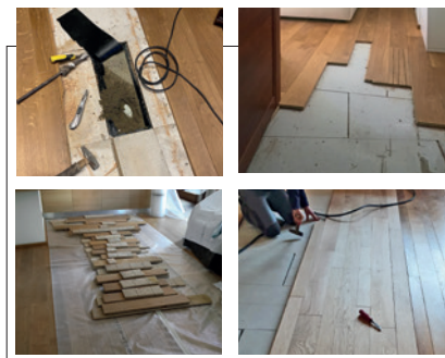
1. Rigonatura sabbia / 2. Stesura frenovapore / 3. Pannello in gesso fibra / 4. Inchiodatura parquet
